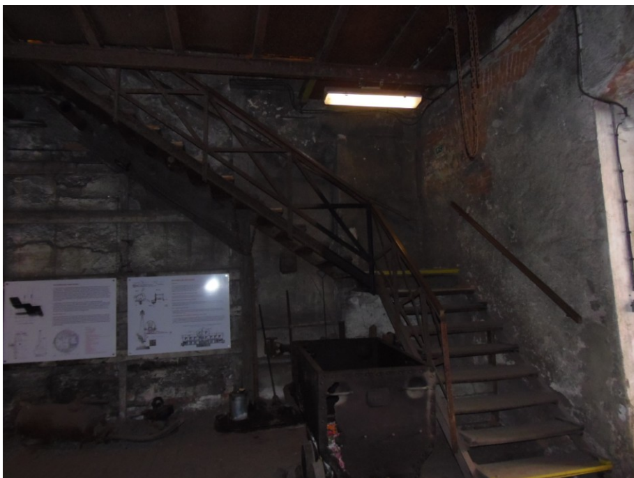
Obr. č. 5: Dvouramenné schodiště z +351,14 vede na +355,74.
