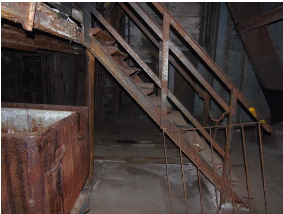
Obr. č. 13: Jednoramenné schodiště na plošinu na úrovni +357,76.
