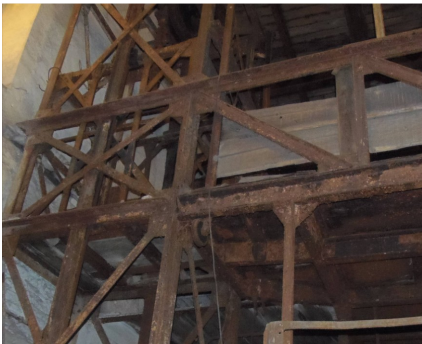
Obr. č. 9: Příhradový vazník - průnik vazníku a věže samotížného výtahu.
