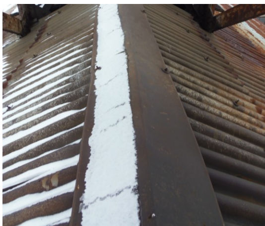
Obr. č. 25: Vlevo plech v hřebeni střechy, vpravo odvodnění vnitř. části věže.
