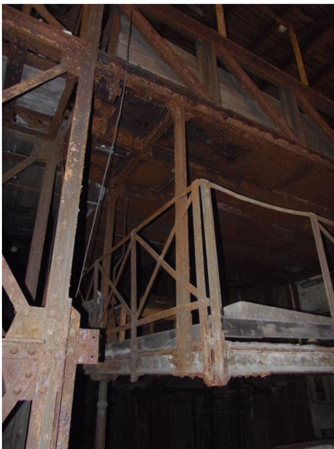
Obr. č. 10: Vyvěšení plošiny na úrovni +357,76 z příhradového vazníku.
