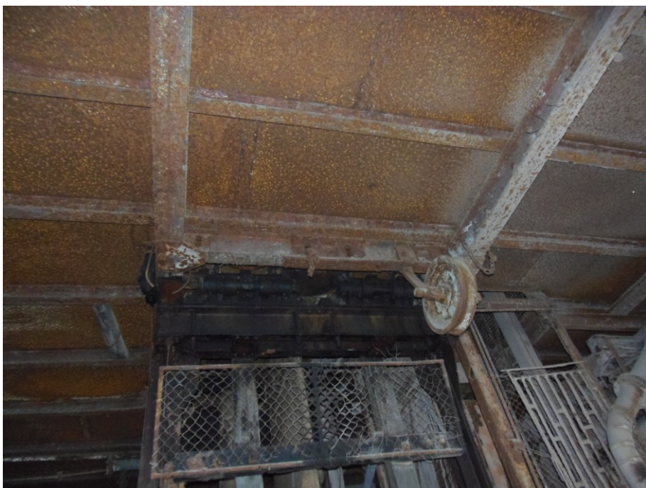
Obr. č. 4: Uložení stropu 1NP na stolicí věže hlavního těžního oddělení.
