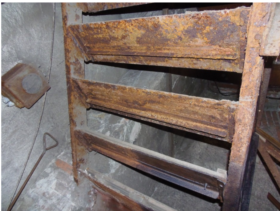
Obr. č. 6: Dvouramenné schodiště - uchycení stupňů.
