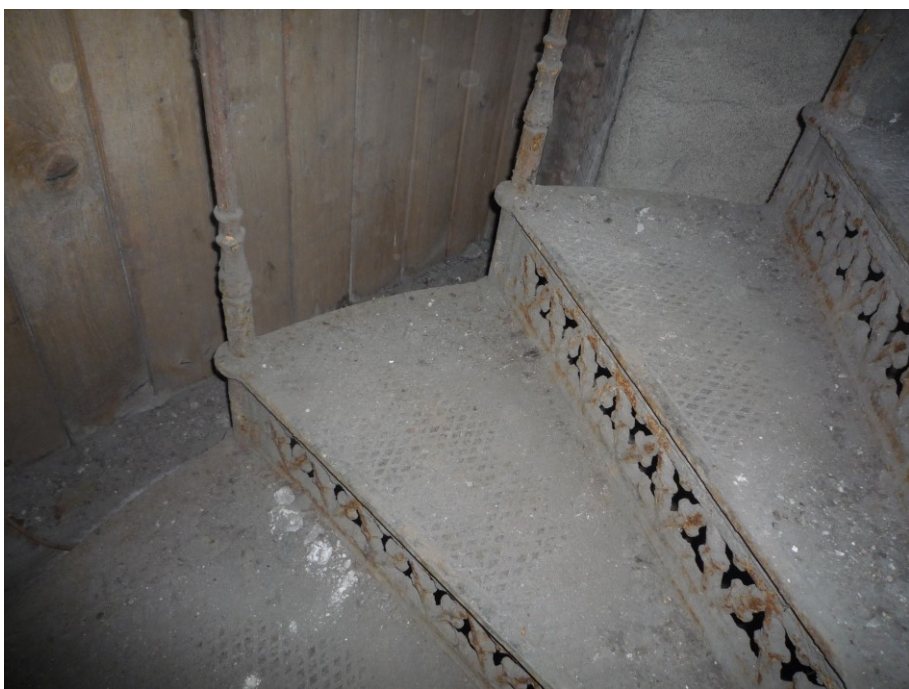
Obr. č. 14: Točité schodiště z litinových stupňů.
