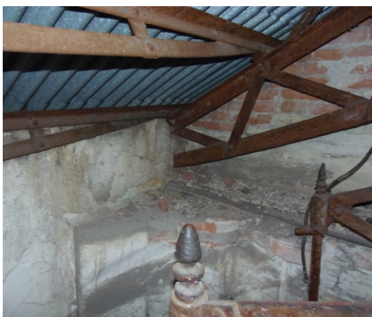
Obr. č. 22: Vlevo uložení vazníku, vpravo pohled na vazník v hřebeni střechy.
