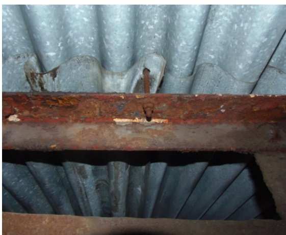
Obr. č. 24: Osazení plechu na vaznice střechy.
