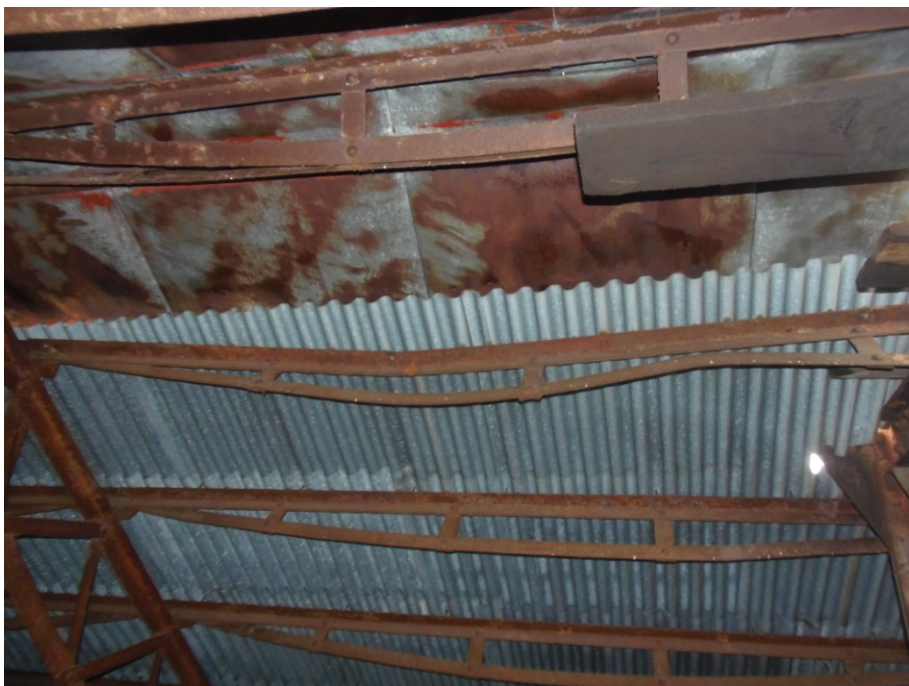
Obr. č. 23: Zdeformovaná vaznice pod hřebenem střechy.
