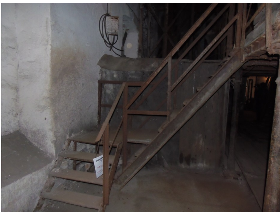
Obr. č. 12: Dvouramenné schodiště na plošinu na úrovni +357,76.
