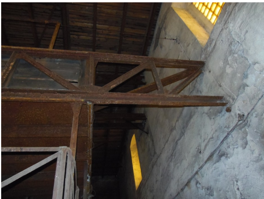
Obr. č. 8: Příhradový vazník - uložení.
