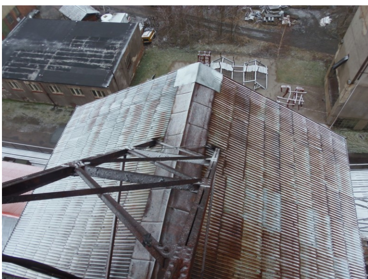
Obr. č. 26: Vzpěra proti směru tahu lan.
