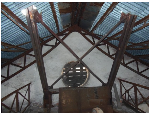
Obr. č. 22: Vlevo uložení vazníku, vpravo pohled na vazník v hřebeni střechy.
