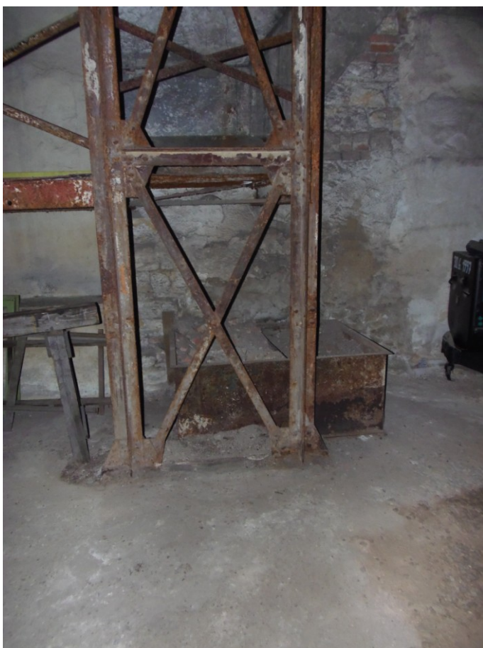
Obr. č. 2: Pata levé věže samotížného výtahu.
