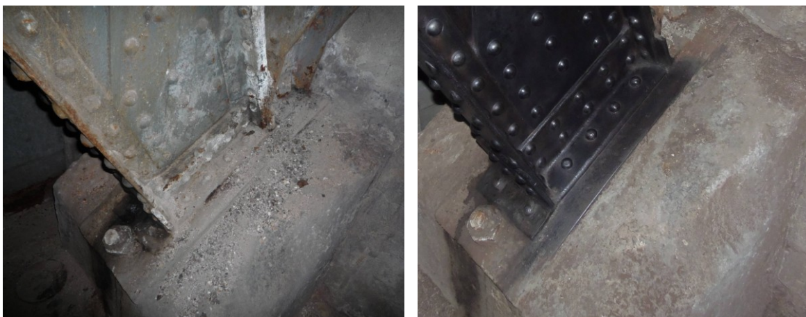
Obr. č. 15: Patka vzpěry. Vlevo před pokusnou konzervací, vpravo po ní.
