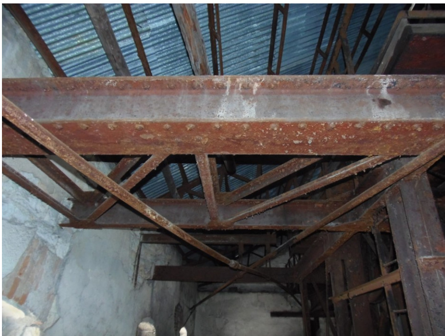
Obr. č. 21: Jedna z dvojic táhel ztužujících budovu na úrovni +367,19.
